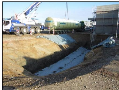
Einbau des 100 m<sup>3</sup> Wasserspeichers im Außenbereich
