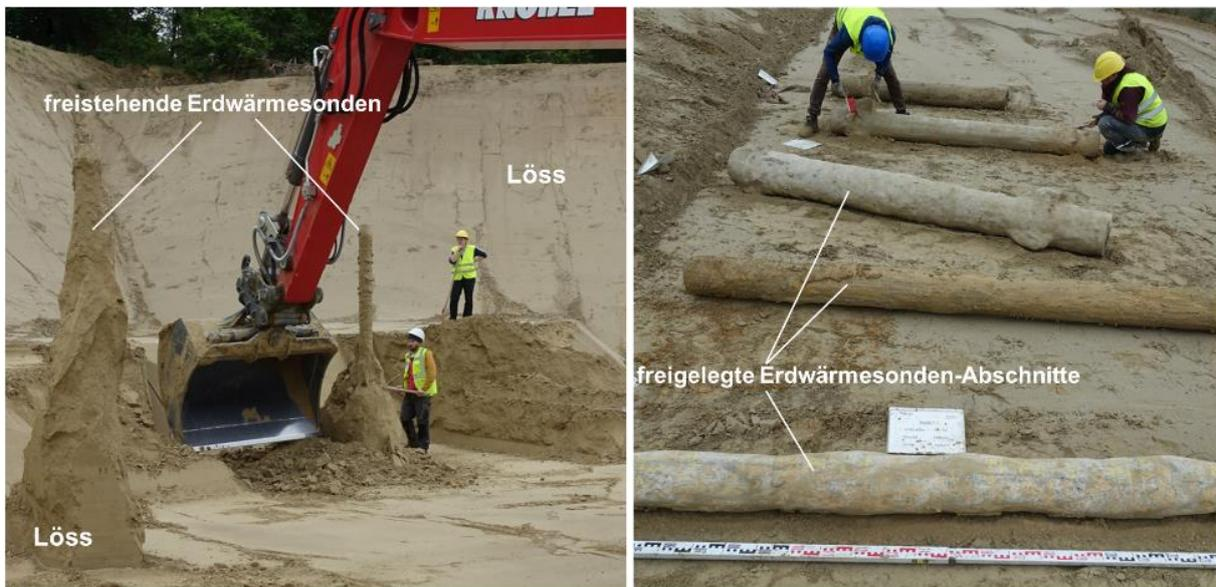
Abbildung 1: Lagerweise Freilegung von im Löss erstellten Erdwärmesonden im Steinbruch (links); Abschnitte mehrerer freigelegter Erdwärmesonden in unterschiedlicher Ausführung werden für die Analyse vorbereitet.
