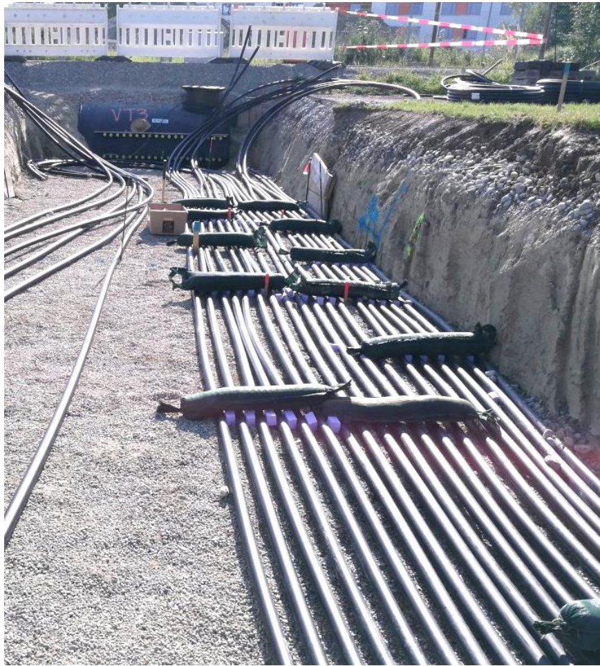
Abbildung 1: Horizontale Anbindetrasse eines Erdwärmesondenfeldes
