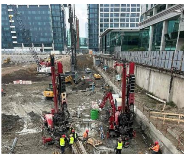
Bauausführung Erdwärmesonden Delta District, Belgrad / Serbien | Quelle: REHAU
