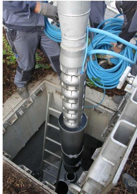
Einbringung der Brunnenpumpe, Pumpe wird in Brunnen versenkt
