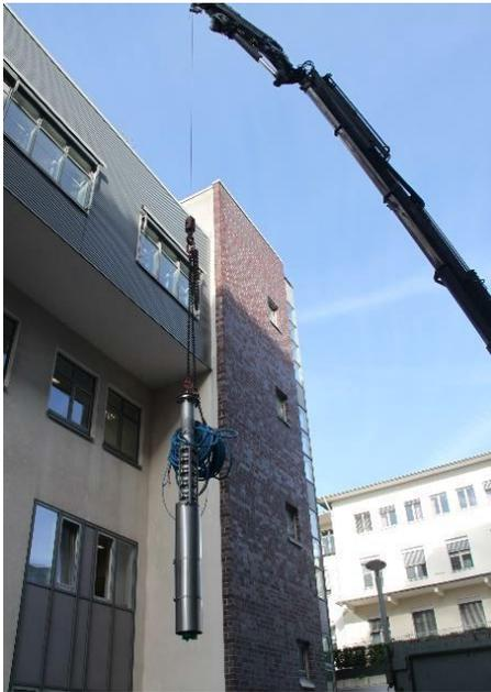
Einbringung der Brunnenpumpe, Pumpe am Kran
